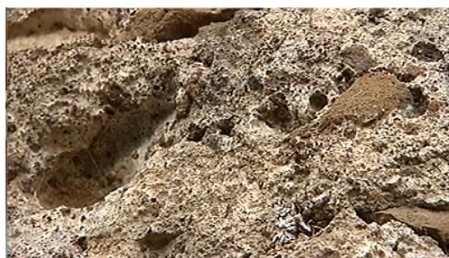
Fig - 2 「パンテオン神殿」での古代コンクリート
