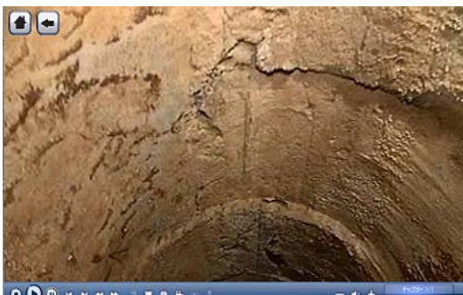
Fig - 9 水道トンネルの天端の コンクリート
