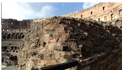
Fig 1 「コロッセオ闘技場」で使用の古代コンクリート
